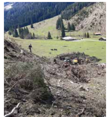
Ausmaß der Zerstörung aufgrund der Lawinenabgänge im heurigen Spätwinter.
